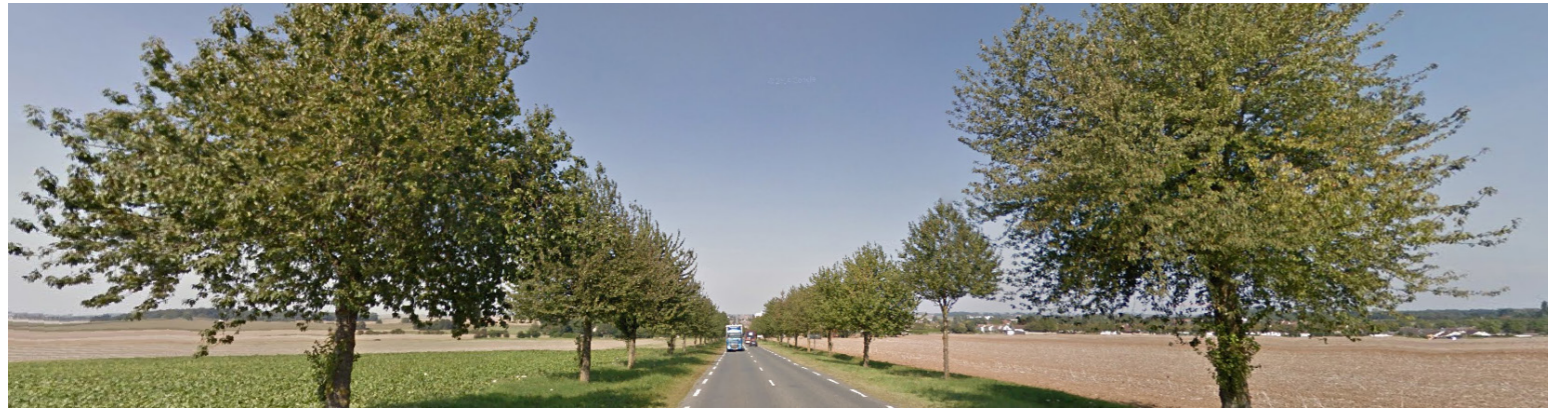
Entrée de ville sud et point de vue identifié par le SCOT. Les bâtiments collectifs d'importante hauteur récemment réalisés rue Théophile Havy sont particulièrement visibles
