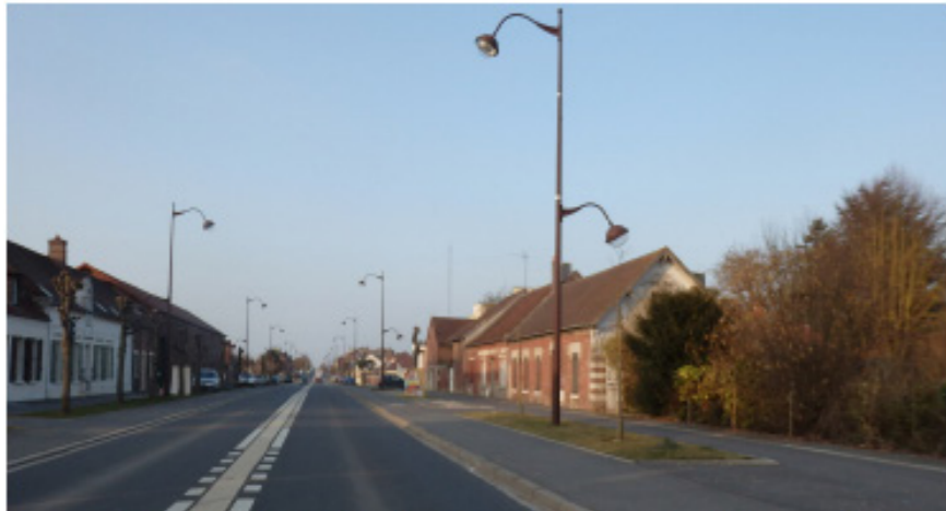
Avenue de Flandres (D1017), implantation du bâti ancien à l'alignement des larges trottoirs.
