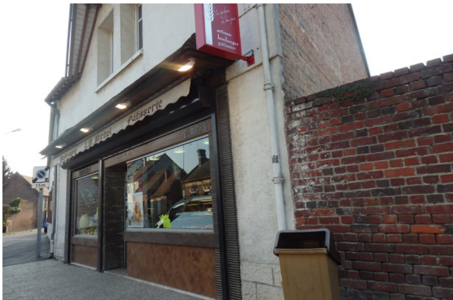
Boulangerie rue Elisa Baré bénéficiant de quelques places de stationnement en façade.
