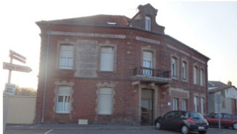
Ancien relais et commerce, lucarne à fronton marquant l'entrée de ville nord.
