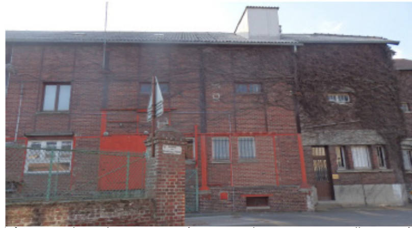
Bâtiment industriel ancien caractéristique en briques rouges vieilles et présentant peu d'ouvertures.
