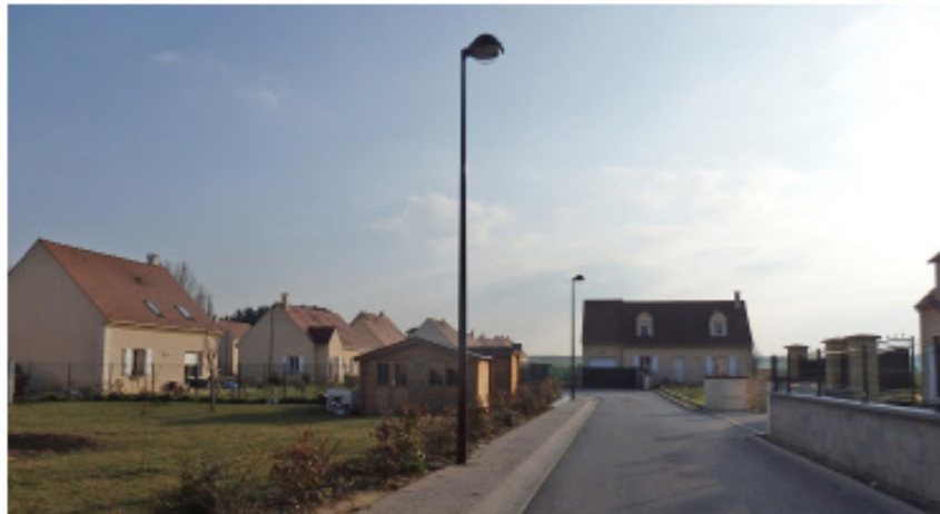
Implantation du bâti ne suivant pas l'organisation traditionnelle du bourg, clôtures végétales et implantation en retrait de rue.
