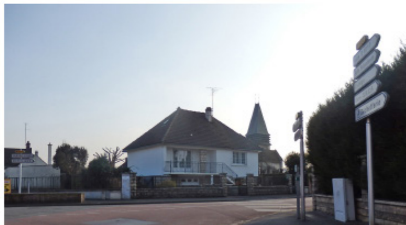
Construction pavillonnaire des années 1960-1970, en covisibilité avec l'église.
