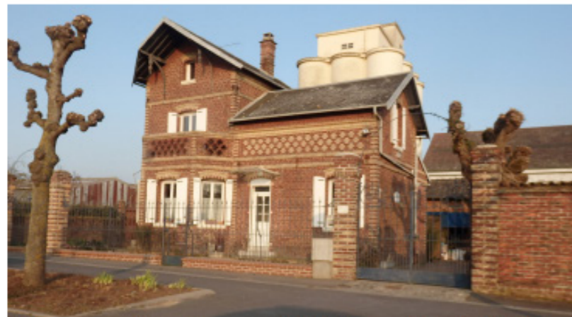
Bâtiment remarquable en briques rouges dominantes, en retrait de l'avenue de Flandres (ère industrielle).
