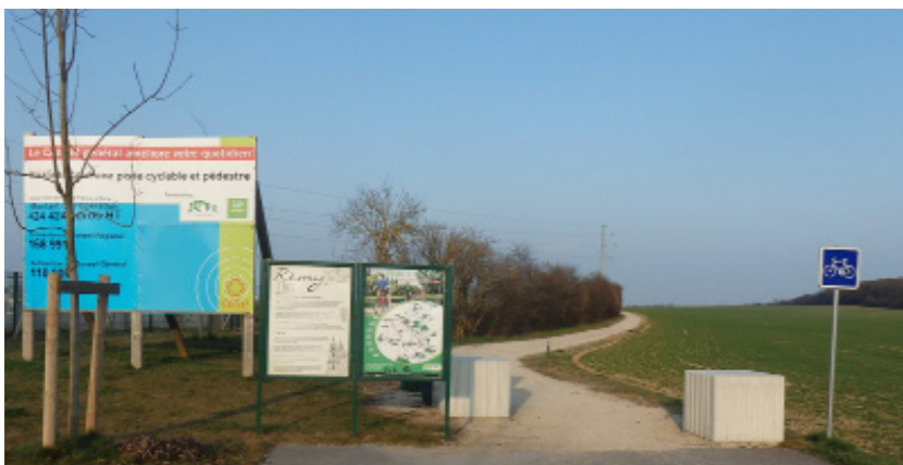
Piste cyclable récemment réalisée au droit de la D36 vers Rémy, puis Compiègne
