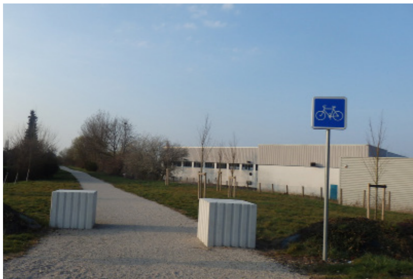
Accès à la Coulée verte qualitativement traitée pour les piétons et les cycles depuis la D36
