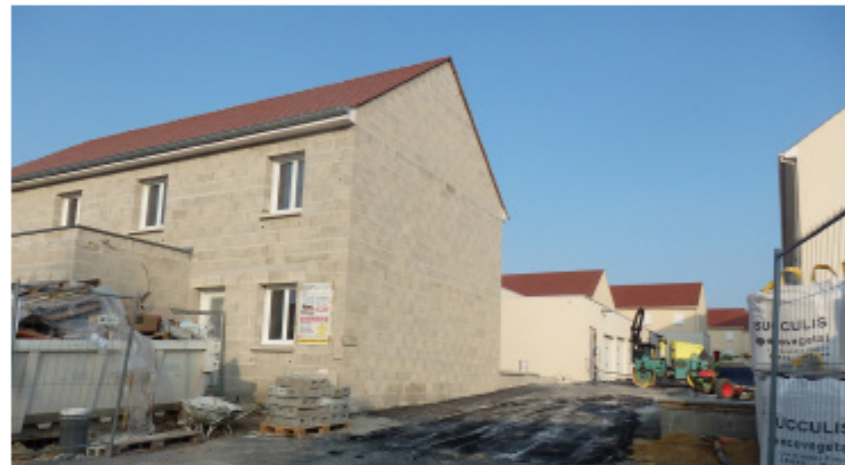
Logements collectifs en cours de réalisation, rue Théophile Havy.
