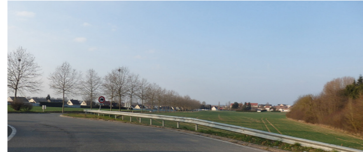
Entrée de ville sud-est depuis Moyvillers et alignement d'arbres. Logements collectifs rue Théophile Havy relativement bien insérés par les boisements
