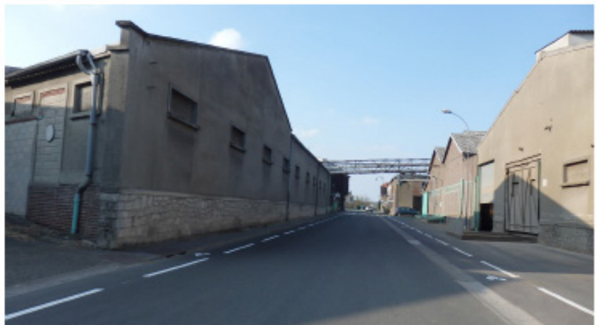
Bâtiments industriels anciens implantés à l'alignement de la D597.
