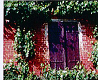
Brique recouverte d'un lait de chaux
