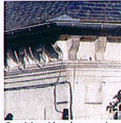
Corniche et bandeau en pierre
