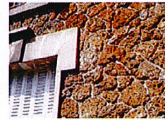
Meulière avec joint creux au mortier bâtard
