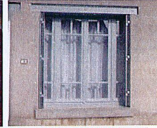
Baie avec linteau et volets métalliques pliants
