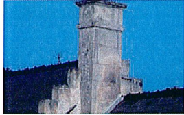
Souche de cheminée en pierre de taille
