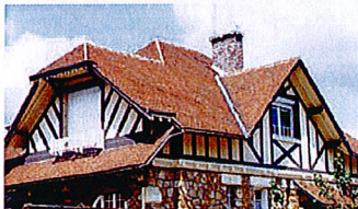
Mouvements de toiture: croupes, noues, ornements sur les rives et les faitages
