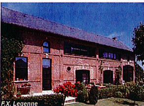
F.X. Legenne Rénovation d'une grange du XIX ème siècle en habitation conservant la volumétrie initiale et le parement brique
