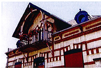
Lucarne centrale avec débord de toiture, boiseries peintes, balcon, lucarne œil de bœuf
