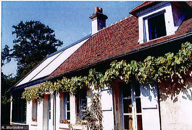
H. Morinière Création d'un espace vitré intégré au volume initial d'une maison rurale
