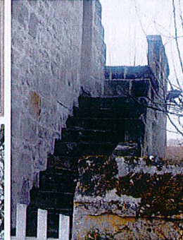
Escalier en pierre sur pignon
