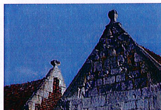
Pointes de pignon avec fleurs du maçon
