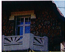
Balcon en béton d'une maison en meulière
