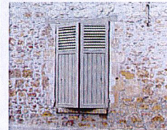
Maçonnerie moellon à pierre vue
