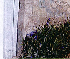
Maçonnerie en moellon avec pierre de taille en structure
