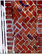
Brique rouge unie, silico-calcaire claire, vernissée et cintrée, badigeonnée en rouge, posée à chevron, formant un escalier ou un couronnement de clôture
