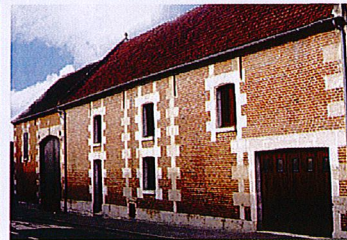
Réutilisation d'une grange en logement
