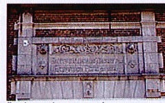
Porche en pierre ouvragée
