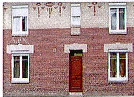
Mur en brique rouge et silico-calcaire
