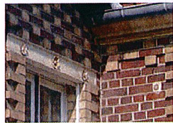
Linteau métallique, modénature en brique silico-calcaire et brique argile
