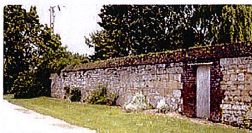
Mur de pierre en blocage avec chaînes et couronnement en brique avec bande herbeuse
