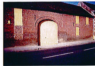
Grange avec porte charretière
