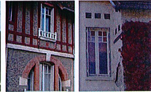
Façade en enduit mouchetés et faux pans de bois
