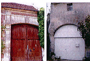
Porche d'entrée avec encadrement ouvragé en pierre
